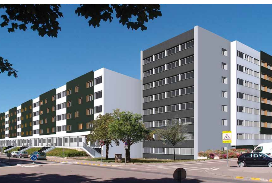
Quartier de la Fontaine-d'Ouche à Dijon
